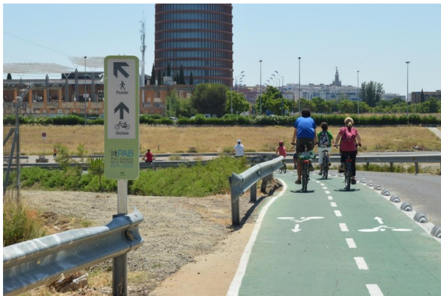
Figura 37: Carril bici existente entre Sevilla y Camas.
