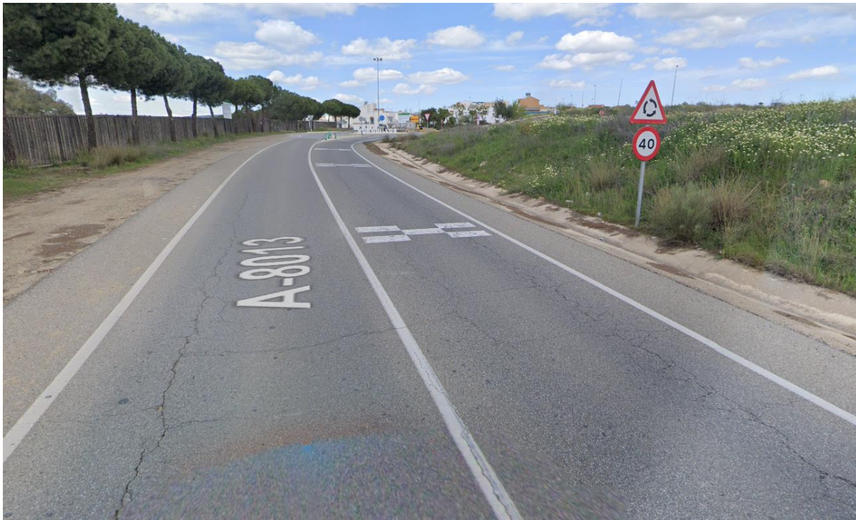
Figura 11: Bandas transversales de alerta a la entrada del núcleo urbano de Burguillos
