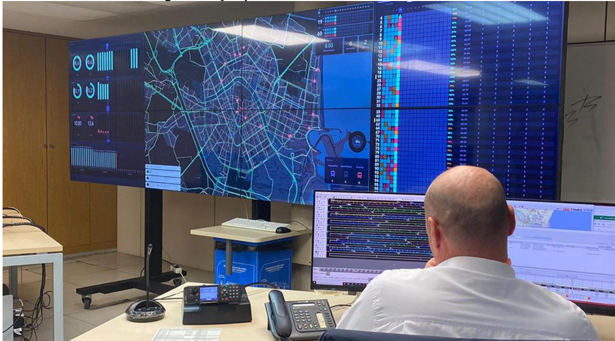
Figura 70. Ejemplo de Centro de Control en Valencia.
